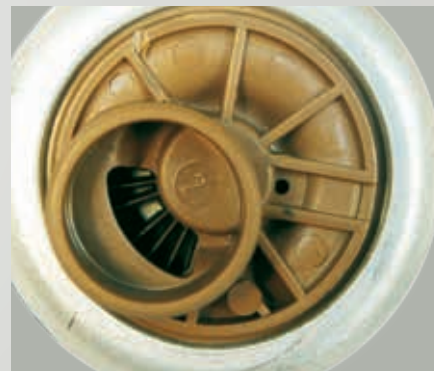
Fig. 35 : Par comparaison : vue du manchon d'aspiration d'une pompe à canal latéral avec une roue d'engrenage intacte (ci-dessous).
